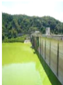
一庫ダム貯水池ダムサイト上流部 H22. 8. 27撮影
